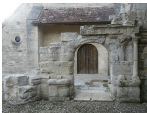
Façade actuelle de l'ancienne église avec le caquetoire en arrière plan.
